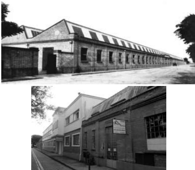
Figura 5: O. De Carvalho: Unidade fabril principal em 1930. Acervo do Depto. de Patrimônio Histórico de São José dos Campos. Detalhe da fachada após intervenção de E.P.S.P e Olivo Gomes, em 1949.
