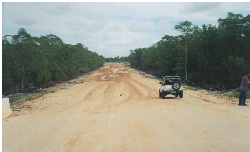
Figura 3: Trecho implantado sobre área de manguezal.
